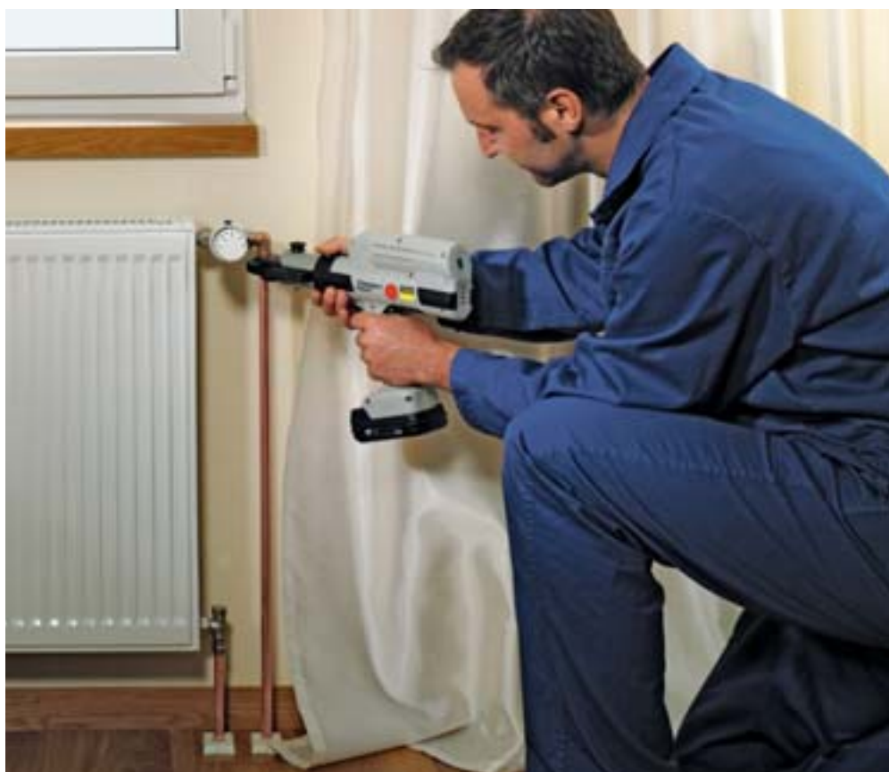
Praca bez pozostawiania śladów: zaciskarką Viega można dotrzeć bez problemu do trudno dostępnych miejsc, nie pozostawiają one żadnych śladów.
